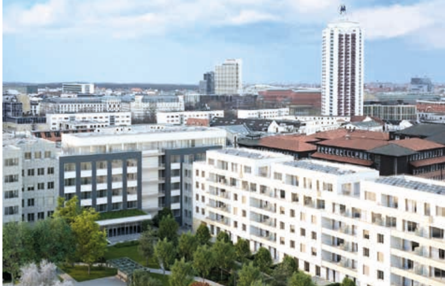
Blick vom Innenhof auf den künftigen Standort der WBG Kontakt.
